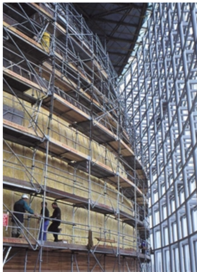
Andamios en zona de construcción en el Parlamento Europeo en Estrasburgo.
