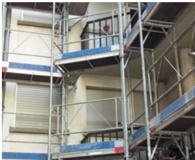
Andamios en zona de construcción en el Parlamento Europeo en Estrasburgo.
